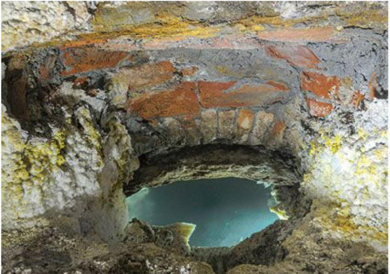
Bild 1: Blick in die Fassung der Hinterhofquelle im Keller des Hotel Bären. Die Quelle liefert jeden Tag rund 60'000 vom mineralreichsten Thermalwasser der Schweiz. Die Ablagerungen um die Fassung stammen von Salz-, Kalk- und Gipsmineralien. Die Quelle wurde vermutlich bereits in der Römerzeit gefasst. Die heute sichtbare Fassung datiert aus dem 16. oder 17. Jahrhundert. (Aus Stadtgeschichte Baden, Verlag hier + jetzt)
